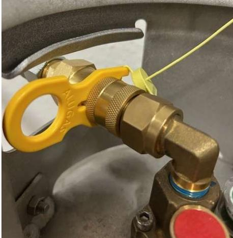
Bild 3 Betätigungsschutz der durch Rettungskräfte zur schnellen Demontage entfernt werden kann.
